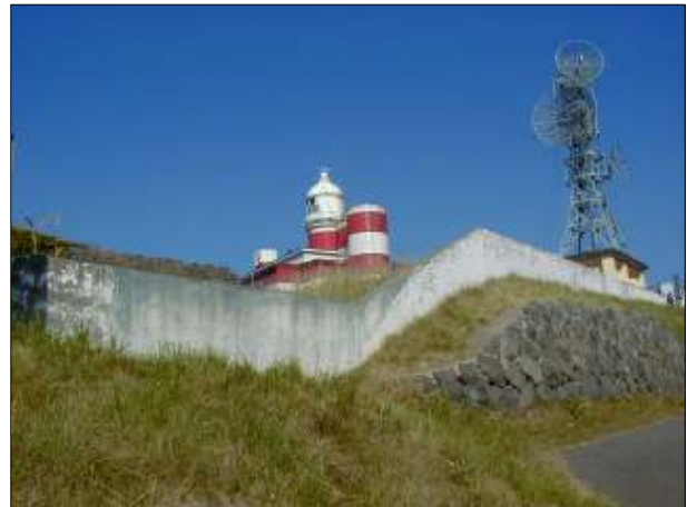
▲ 小樽・日和山灯台
